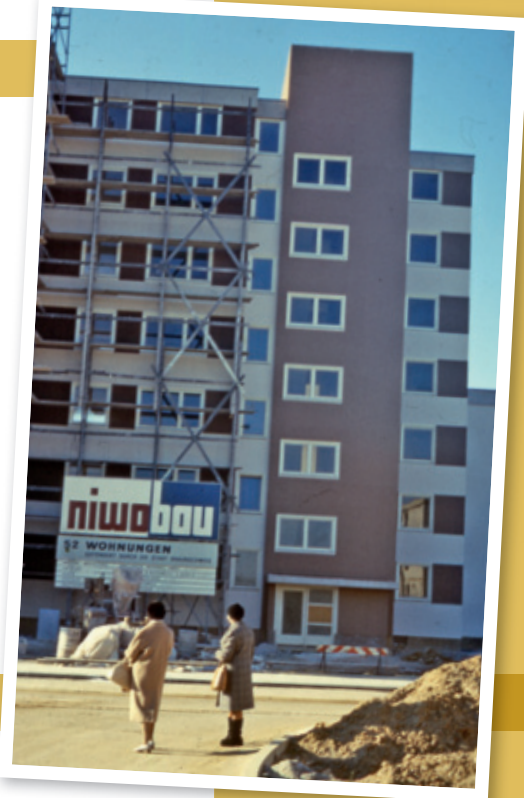
Bau der Gebäude am Ilmweg Anfang der 1970er
