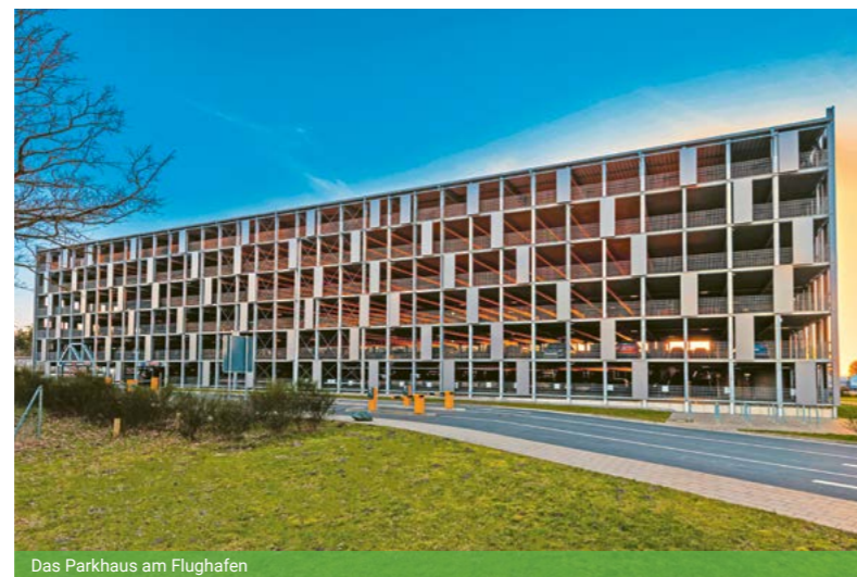
Das Parkhaus am Flughafen
